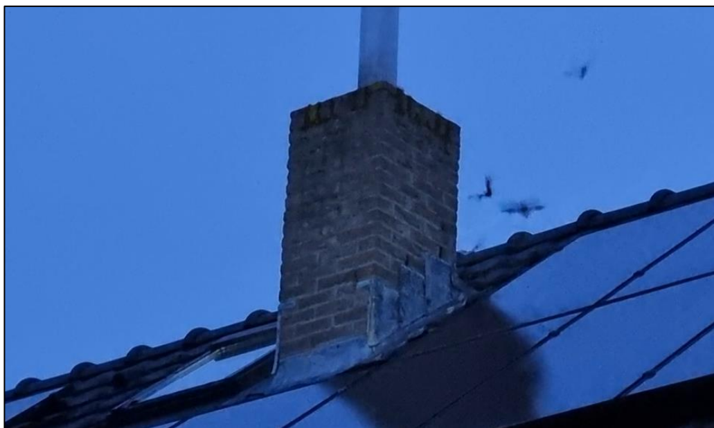
Figuur 3.2 Het kraamverblijf van de gewone dwergvleermuis aan de Nobelstraat 14 met zichtbaar 4 gewone dwergvleermuizen rondvliegend bij stootvoegen.
