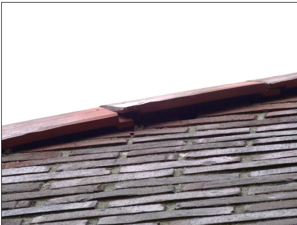
Wat grotere kieren tussen windveerpannen en de gevel bieden geschikte invliegopeningen voor gierzwaluwen.
