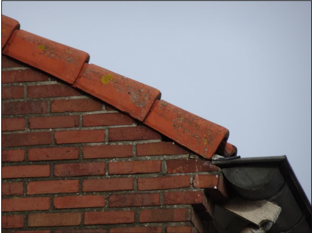
Tussen windveerpannen en de gevel zijn kieren aanwezig die geschikt zijn voor invliegopeningen van vleermuizen.
