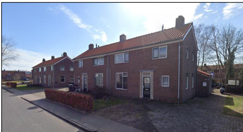
Huidige situatie Spronksweg gezien van de kruising met de Beeklaan (bron: Google Maps).
