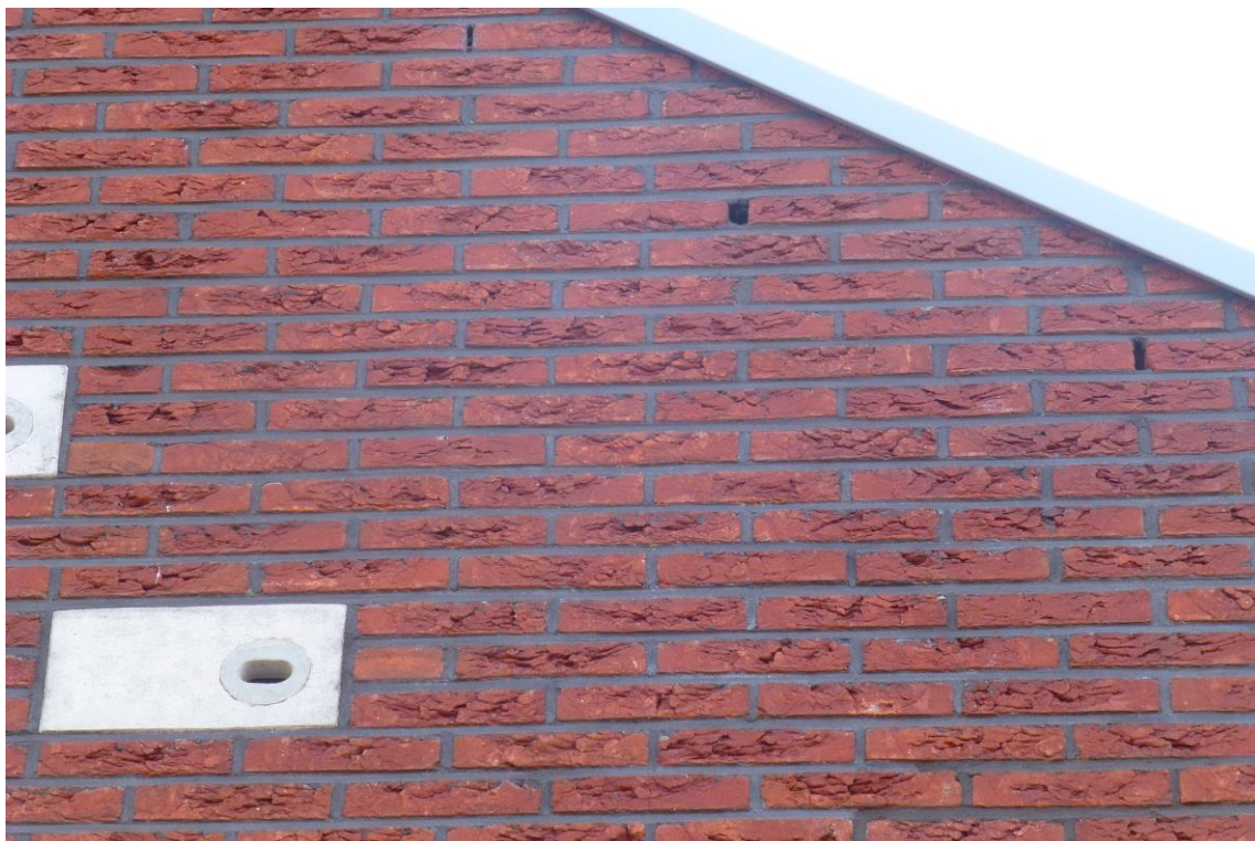
Figuur 5.9 Een voorbeeld van natuurinclusief bouwen: een neststeen voor gierzwaluw (linksonder) en open stootvoegen die de spouw voor vleermuizen toegankelijk maken. Bron foto: Ecogroen, 2021.
