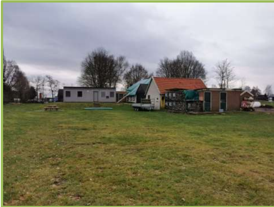
Toiletgebouw en portacabins
