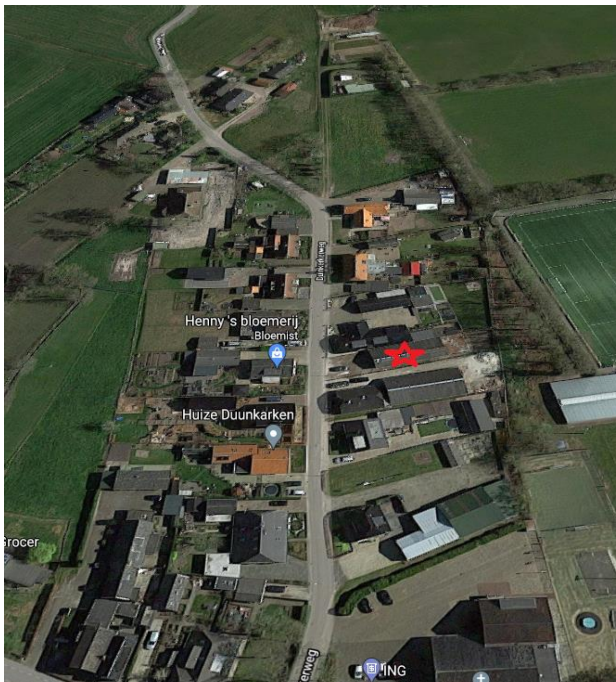
Overzicht bebouwing Duinkerkerweg
