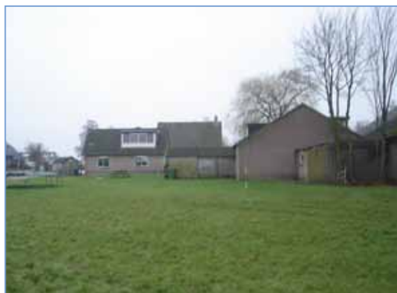
Achterzijde van het perceel
