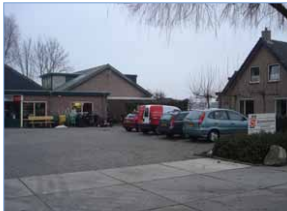
Oostelijk deel van het erf. Brede oprit en veel verharding.
