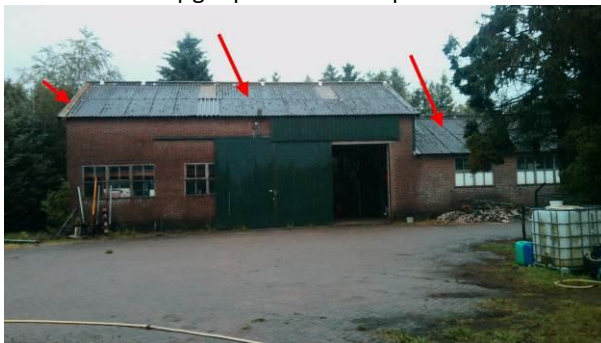
Foto 7 | golfplaten met hulpstukken op het dak
