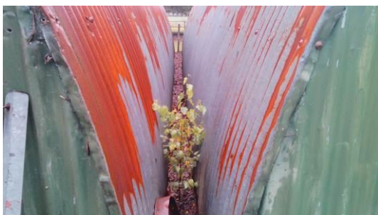
Ruimte tussen de loodsen
