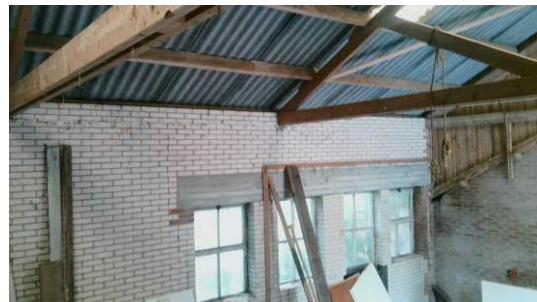
Houten kapconstructie gemetselde muren
