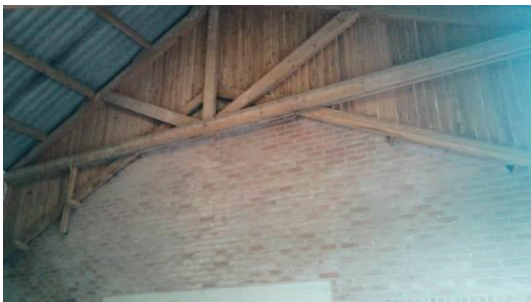
Aangebouwde lager liggend dak
