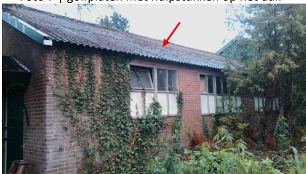
Foto 9 | golfplaten met hulpstukken op het dak
