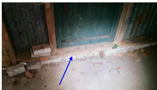
Betonnen banden
