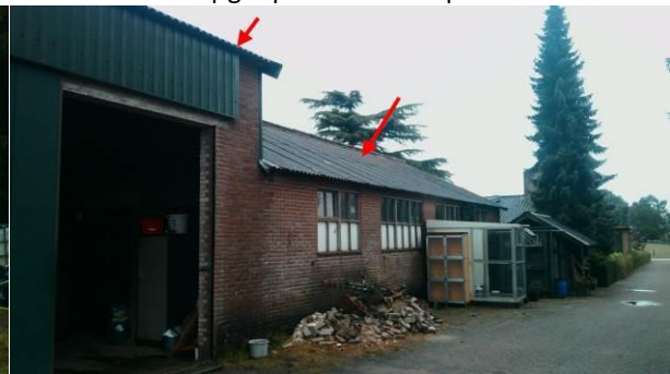
Foto 8 | golfplaten met hulpstukken op het dak
