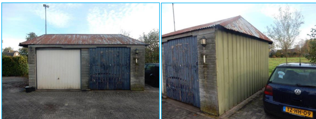
Foto's: Indrukken plangebied. Fietsenstalling.
