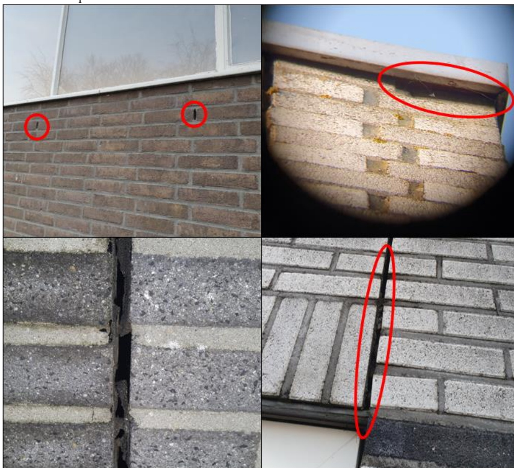
Figuur 4 Openingen welke mogelijk toegang bieden tot de spouw in de gevel van het buurthuis aan de Schiksweg 27 te Oosterwolde. Openingen zijn rood omcirkeld.
