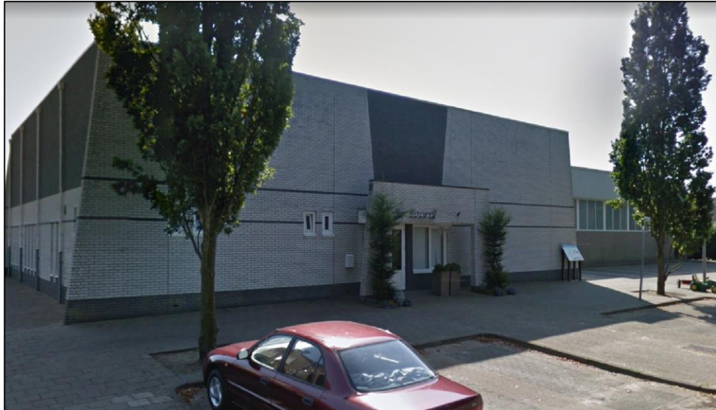
Figuur 1.2 De bebouwing op de planlocatie betreft een dorps huis met twee bouwlagen en een plat bitumen dak.
