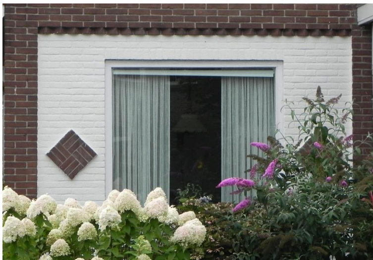
Hiernaast een wit geschilderd gevelvlak dat aan de bovenzijde is afgezet met een muizentand met daarin één afwijkend gemetselde ruitvorm.
