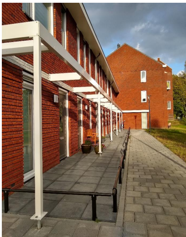
Boven een stalen constructie
