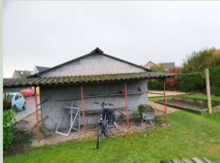
Te slopen bebouwing
