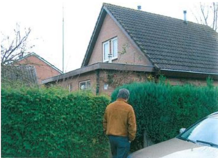
De huidige bebouwing, gezien vanaf de Wildekampsweg
