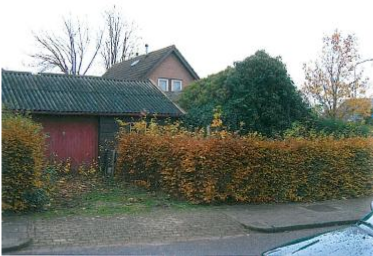
De huidige bebouwing, gezien vanaf de Houthakkersweg
