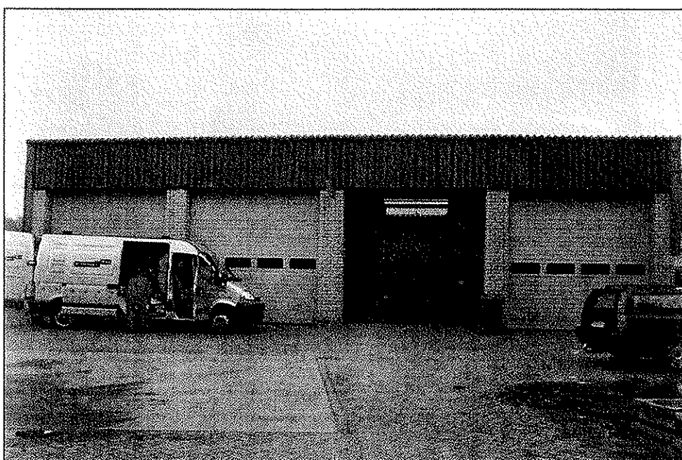
Deellocatie H - opslag klein materieel
