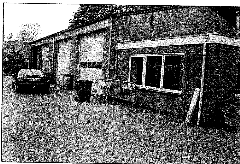
Deellocatie D - ondergrondse tank afgewerkte olie en Deellocatie E - opslag smeerolie
