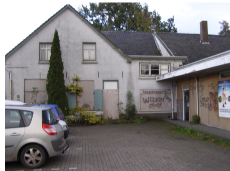
Foto 1 één van de te slopen panden (oosten projectgebied)
