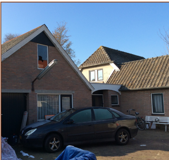
Afb. 3.5: Woning en bijgebouwen gezien vanaf achterkant oprit.
