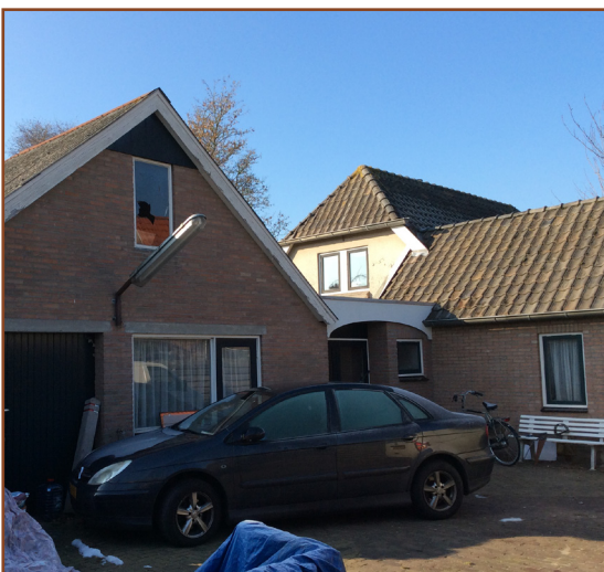
Afb. 3.5: Woning en bijgebouwen gezien vanaf achterkant oprit.
