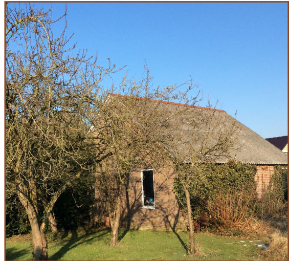
Afb. 3.4: Bijgebouw met golfplatendak, op de voorgrond kleine fruitbomen. Het gebouw is, net als de overige gebouwen, ongeschikt voor vogels en vleermuizen.
