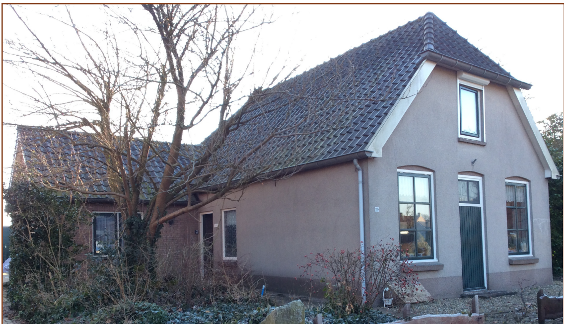
Afb. 1.2: De te slopen woning met links een gedeelte aanbouw. De foto is genomen vanaf de Kerkweg.
