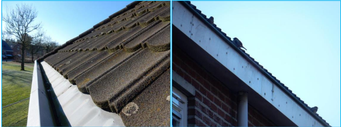
Foto's: Ongeschiktheid daken voor huismus en gierzwaluw en enkele huismussen in woonwijk.
