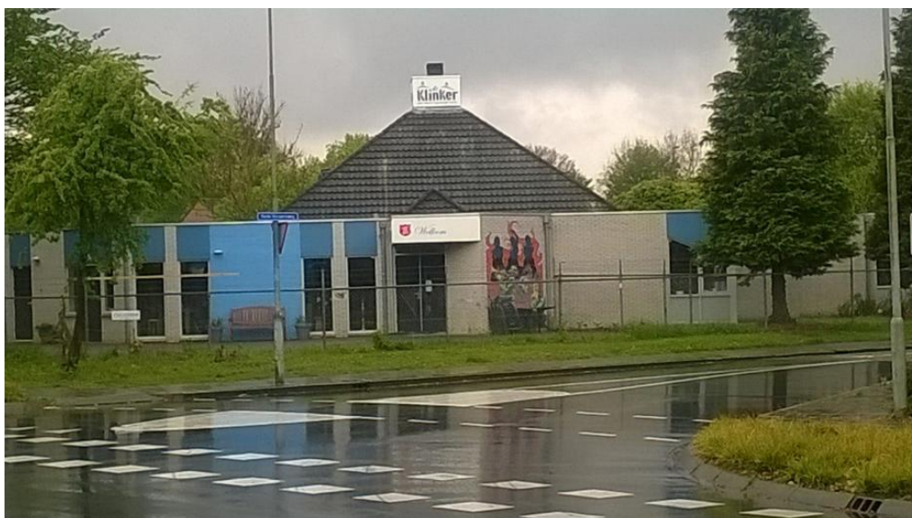
Zicht op het huidige gebouw vanaf de Stationsweg.
