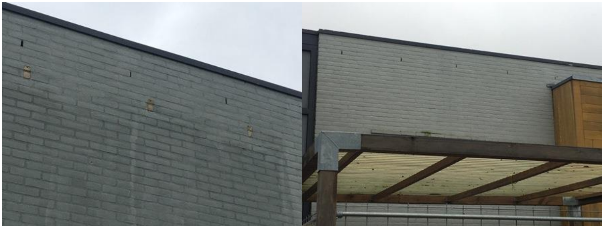
Aanzicht op de buitengevels met open stootvoegen.
