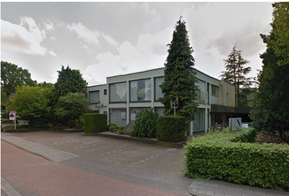
Voorzijde plangebied, gezien vanaf de Stationsweg (richting het zuidwesten)
