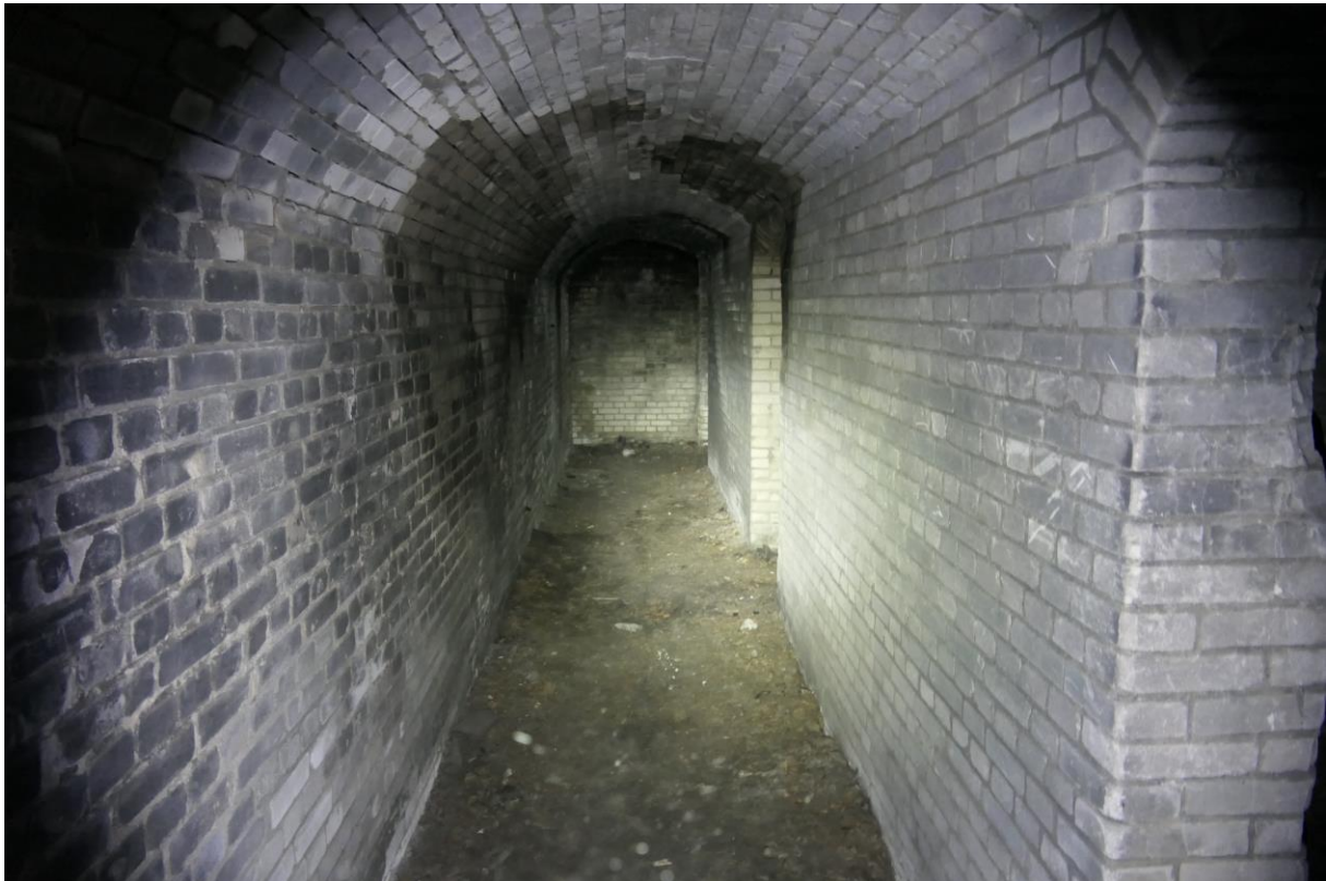
Figuur 4.4 Deel van de binnenzijde van de bunker.
