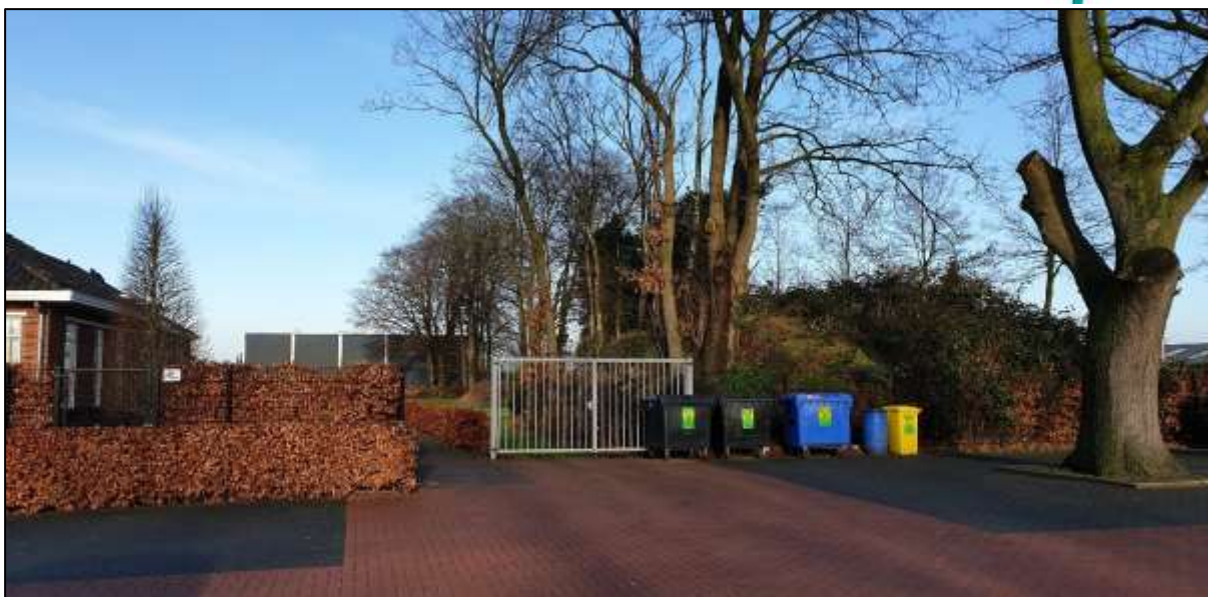
Figuur 2.6 Plangebied gezien vanaf de parkeerplaats in het zuiden. Het plangebied ligt achter hek, met rechts de begroeiing op de bunker.
