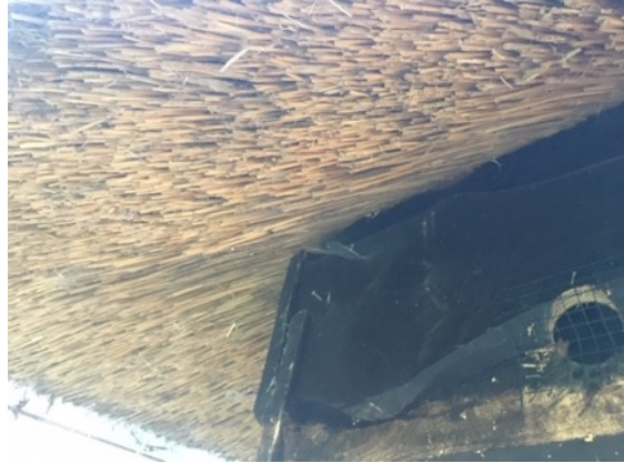
Afb. 3.6. Overgang rieten dak en muur
