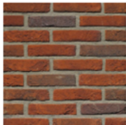
rood tot roodbruin metselwerk
