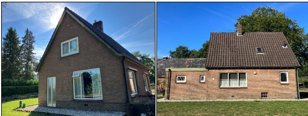
Figuur 2.3 (links): Aanzicht noordzijde woonhuis; Figuur 2.4 (rechts): Aanzicht oostzijde woonhuis.
