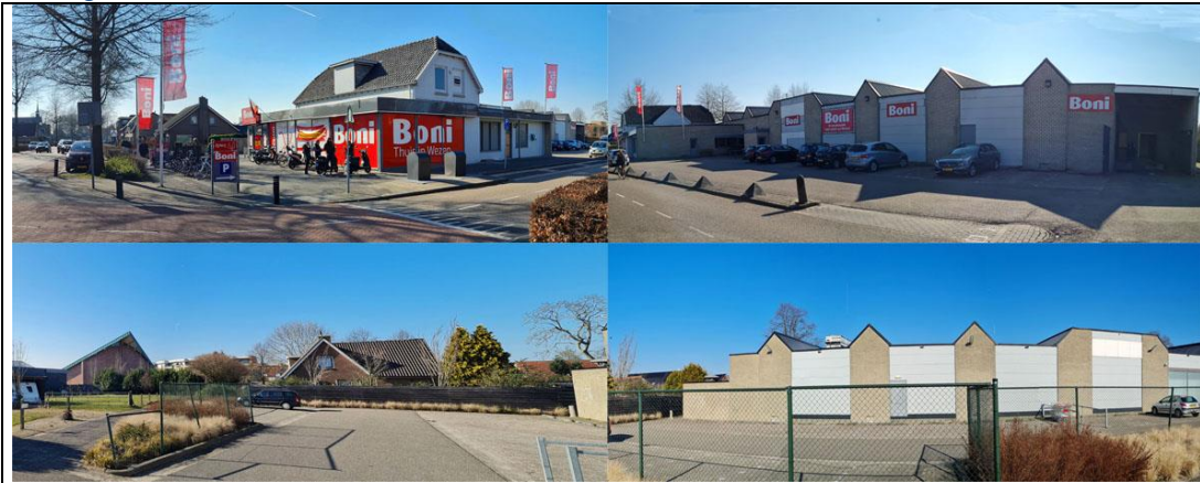
Afbeelding 4: Foto's bestaande situatie.
