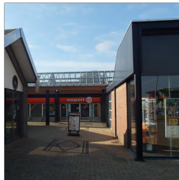
Behoud huidig aanbod uitdaging voor Meidoornplein
