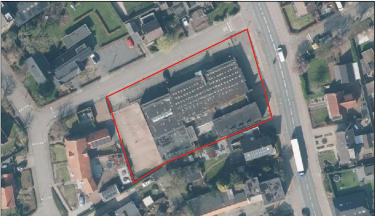
Afbeelding 2.1: Luchtfoto huidige situatie plangebied (Bron: PDOK)
