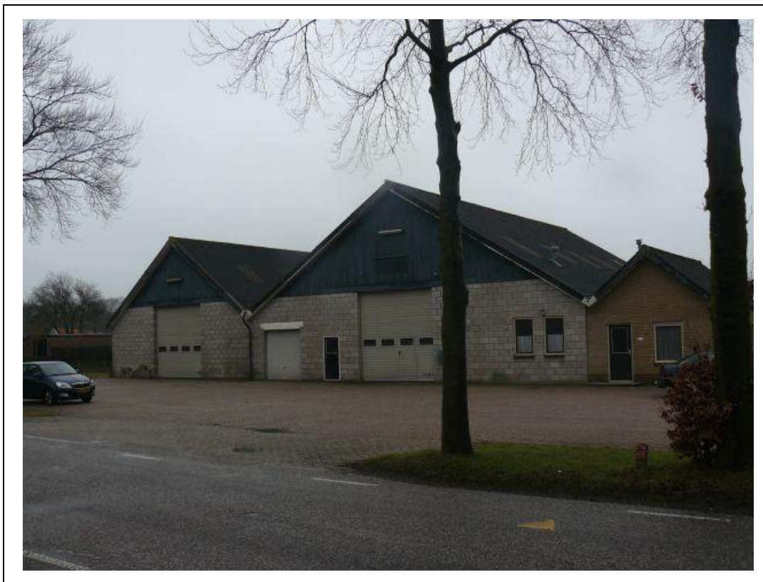
Foto 1. Te slopen bebouwing, oostelijk deel onderzoekslocatie.
