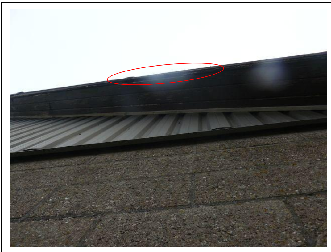
Foto 8. Een van de openingen in de gootbekisting.
