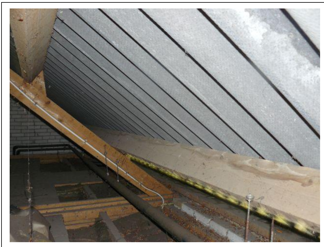
Foto 6. Zolderruimte op kantoorgebouw.
