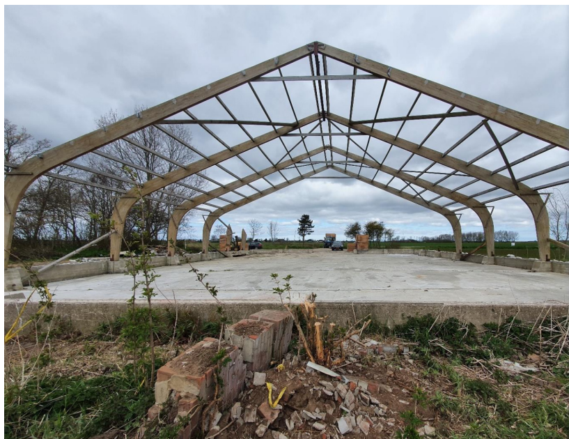
Bestaande situatie geraamte oude schuur
