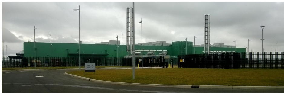
Oostgevel hoofdgebouw met entree bestaande datacenter-campus Microsoft
