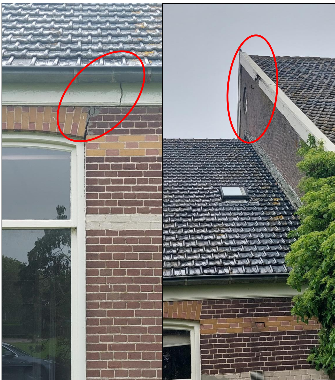
Figuur 5 | Kieren in de muur, gaten in boeideel en ruimte er onder in element 5a en 5b van Figuur 2.
