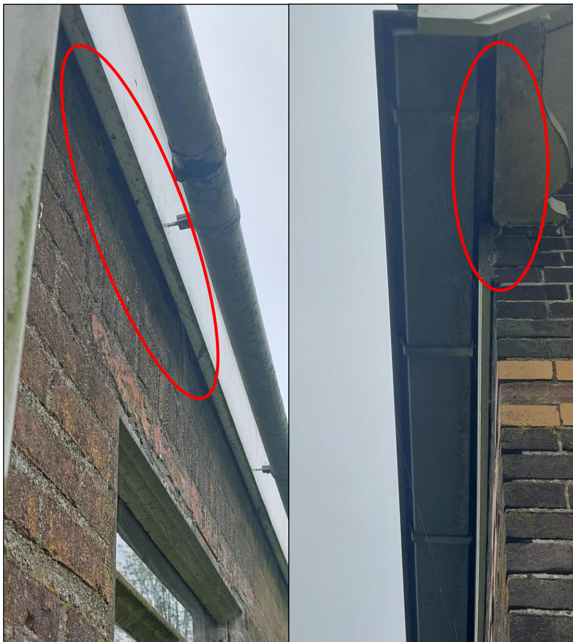
Figuur 6 | Ruimte onder de boeidelen en dakgoot in element 5a van Figuur 2.
