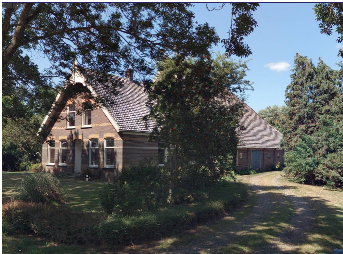
Figuur 3 | Stolpboerderij te Noord Zijperweg 55
