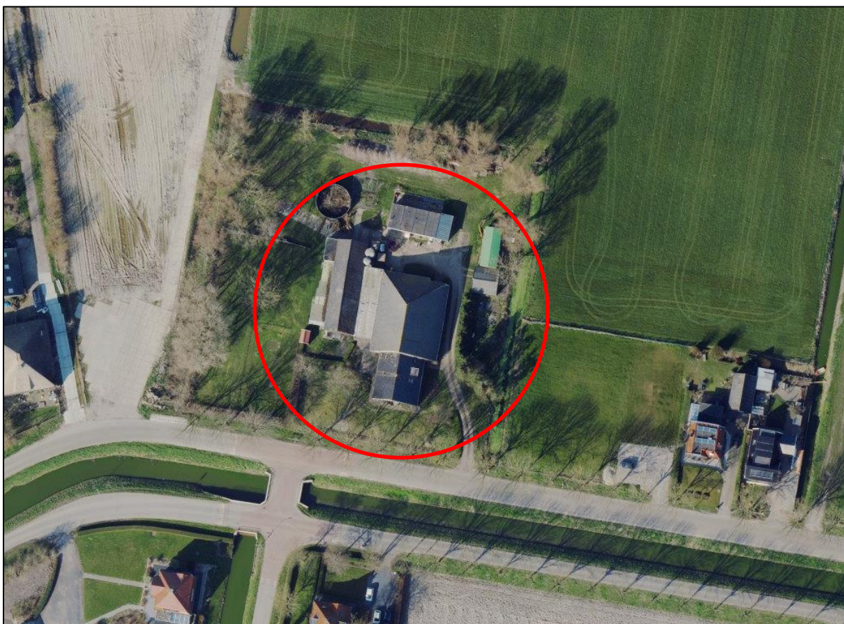
Figuur 2 | Planlocatie Noord Zijperweg 55 (Bron: Cyclomedia 2022)
