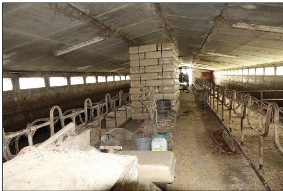
Afbeelding 10. Te slopen rundveestal (binnen).
