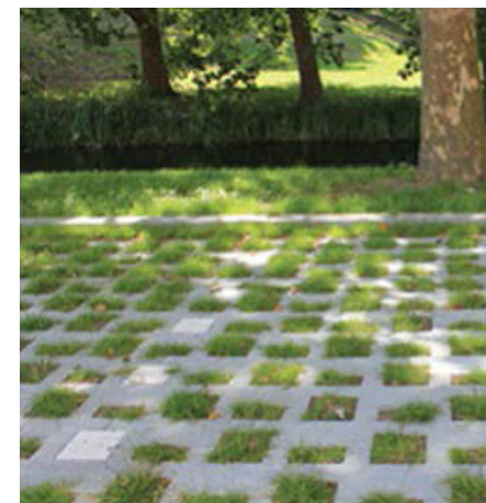
Referentie, parkeerplaatsen met grasbetonstenen
