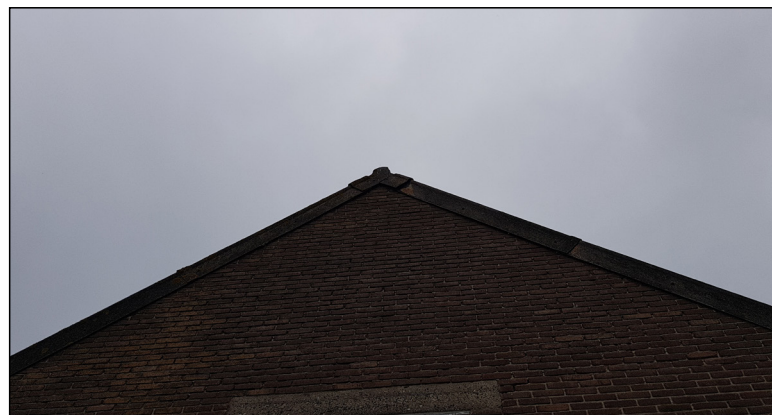
Figuur: de grote schuur heeft kopgevels waarvan de dakrand iets overhangt. Hieronder kunnen vleermuizen verblijven.
