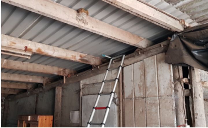
Figuur: op de verhoging in de meest noordelijke schuur, zijn mogelijke nest- of rustplekken in de ruimtes tussen de spanten (zie bijvoorbeeld bij de ladder en de afbeelding hiernaast).
