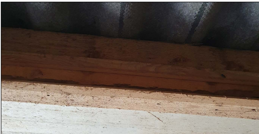
Figuur: bij de inspectie bleken grote delen van het dak niet toegankelijk vanwege de tussenbalken in het dak. Alleen de onderste secties waren toegankelijk en zijn geïnspecteerd.
