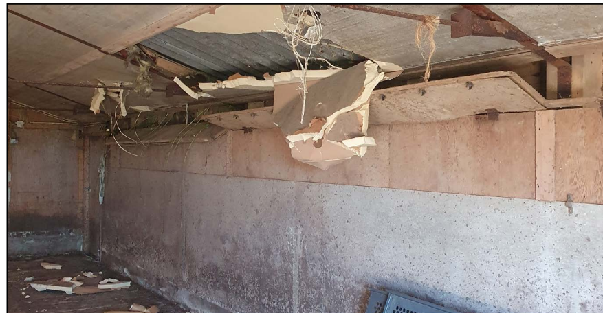
Figuur: ruimtes tussen de isolatie- en de dakplaten werden geïnspecteerd via aangebrachte gaten.
