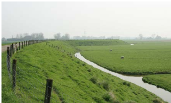
Karakteristiek beeld Westfriese dijk
