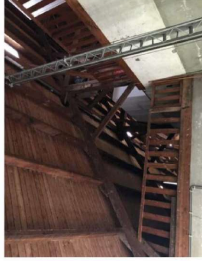
plaatsen puien rondom vide
