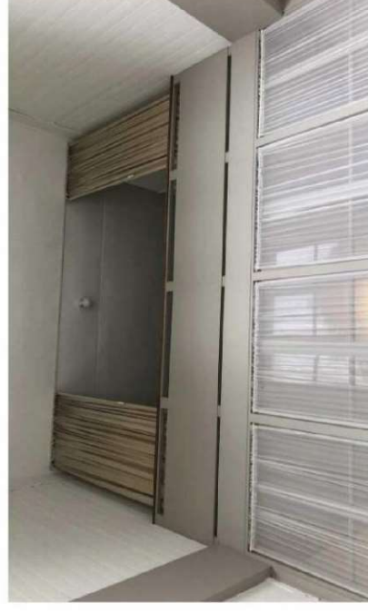
plaatsen puien rondom vide
