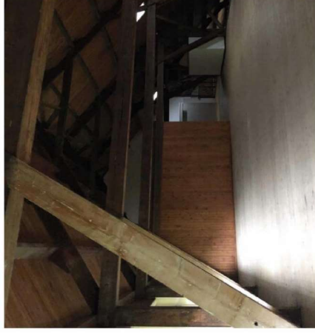
plaatsen puien rondom vide
