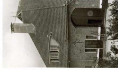
reconstructie oorspronkelijke dakkapel
