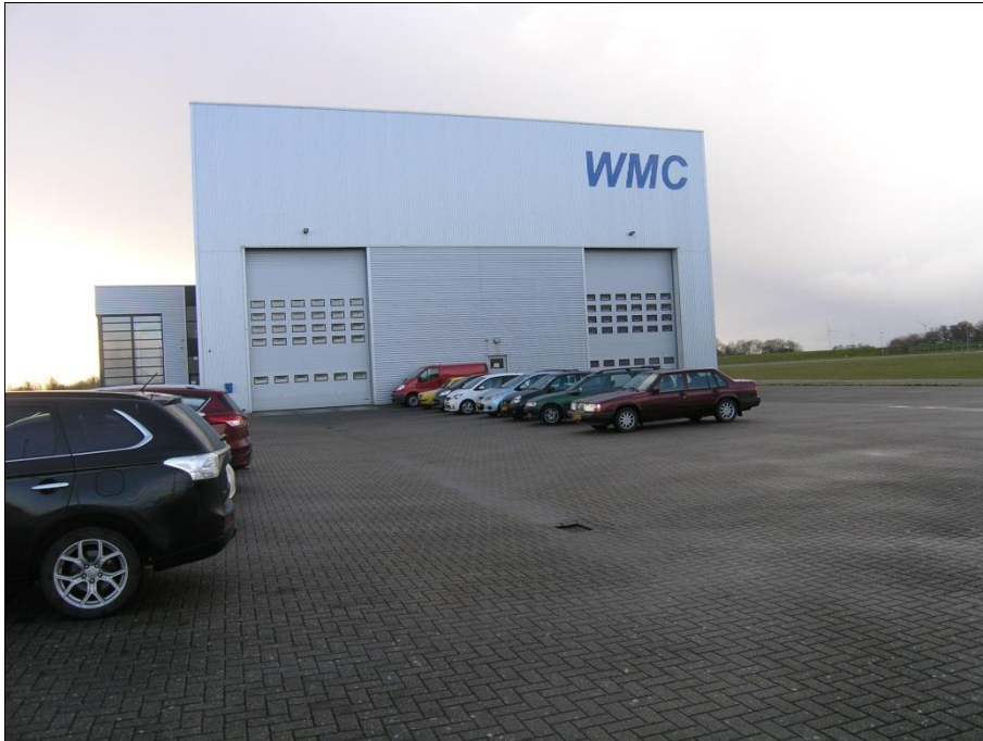
Plangebied met de potentiële uitbreidingslocatie ten noorden van de bestaande loods (2 februari 2018)
