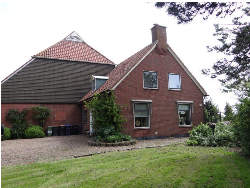
Foto 1. Het woonhuis met de hieraan verbonden grote schuur. Foto genomen in noordoostelijke richting.
