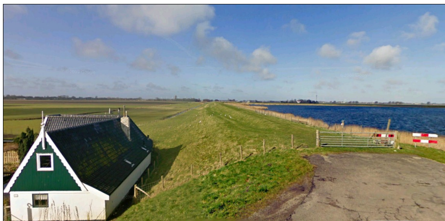
Foto 2. Zicht vanaf de Nieuwe Sluis op (en over) het plangebied (bron: Google)
