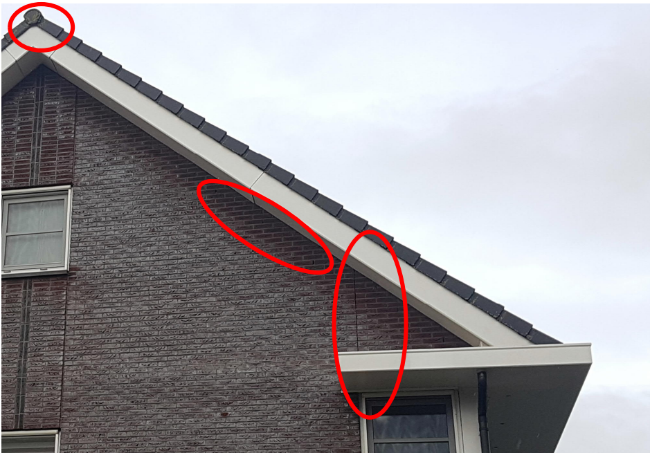
Figuur 3.1 Open stootvoegen en dilatatievoegen in de bebouwing aan de westkant van het projectgebied, mogelijk geschikt als verblijfplaats voor gebouwbewonende vleermuizen.
