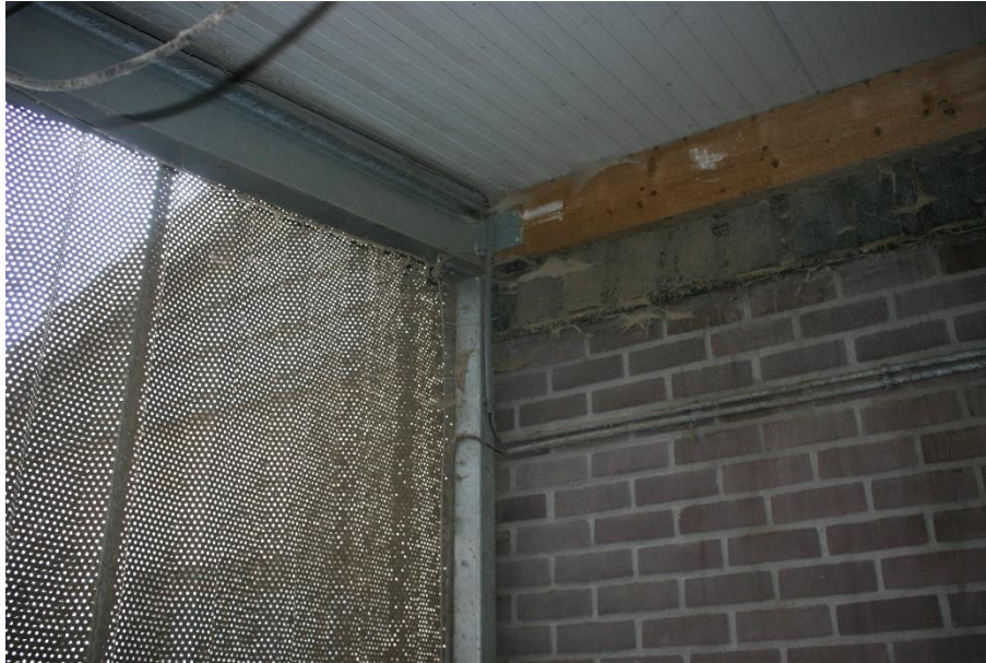
Figuur 4.4.2. De constructie van de binnenzijde van de aanbouw. Deze is dermate afgesloten dat vleermuizen of vogels niet de binnenzijde kunnen bereiken.
