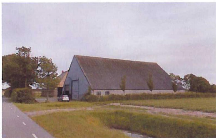
Figuur 7: Foto van reeds gesloopte kapschuur vanaf de Kleiweg (bron: Globespotter)
