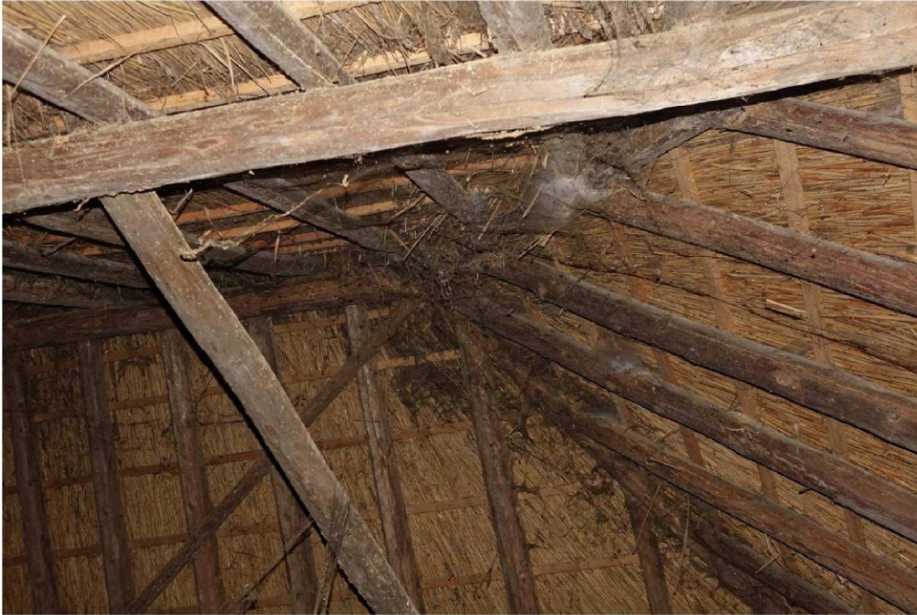
Figuur 4. Inspectie van de binnenzijde van de dars, achter het schuurschot van de woonboerderij.
